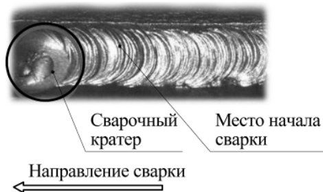
Рис. 10.4. Начало сварки при смене электрода.
